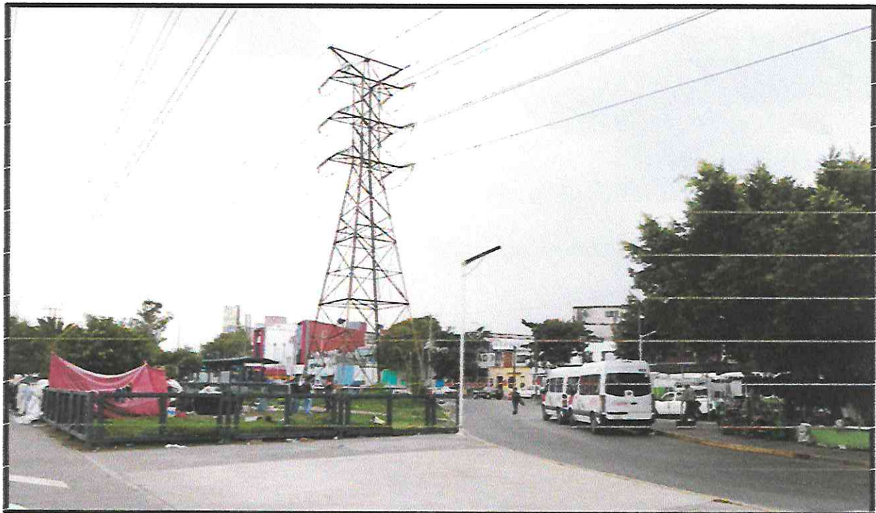
ASENTAMIENTO IRREGULAR Y PUESTOS
